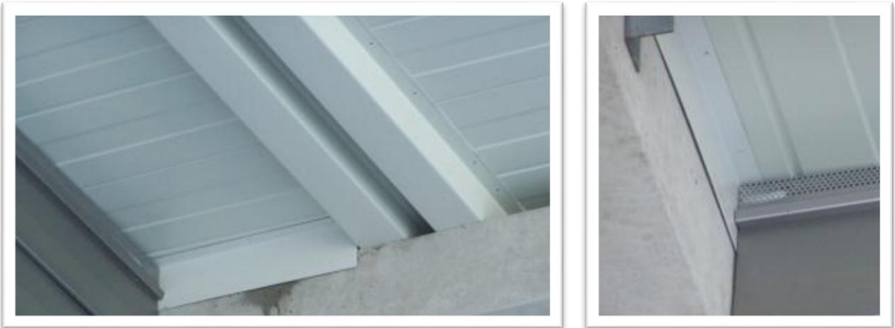
Abb. 7: Pass-Stück zwischen Elementdach und Traufe
