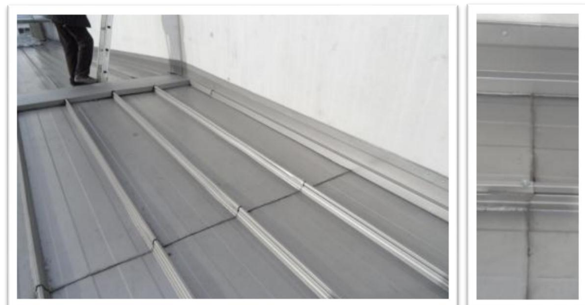
Abb. 8: verschraubte Stoßausbildung Eindeckung Zwischenbau
