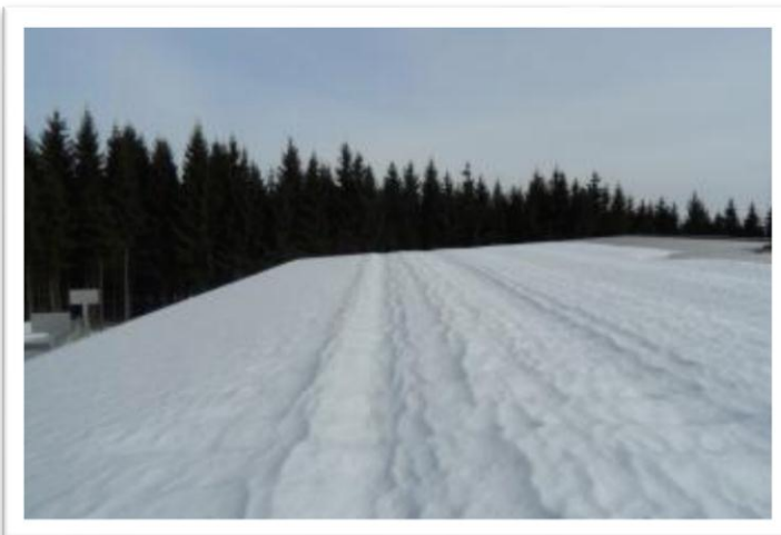
Abb. 3: Dachresche Vordach Montagehalle
