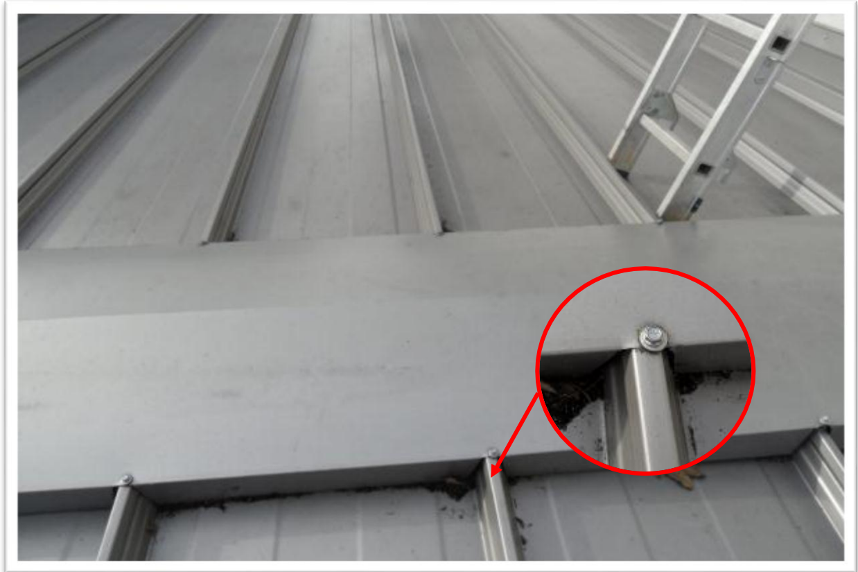
Abb. 9: Verschraubte Firstkappe Zwischenbau
