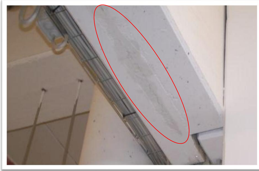
Abb. 11: Durchfeuchtung Wärmedämmung Wandplatte
