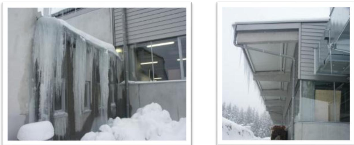
Abb. 2: Vereisungen Hallentraufe zum Zwischenbau
