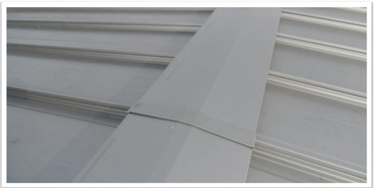
Abb. 10: Eingehängte Firstkappe
