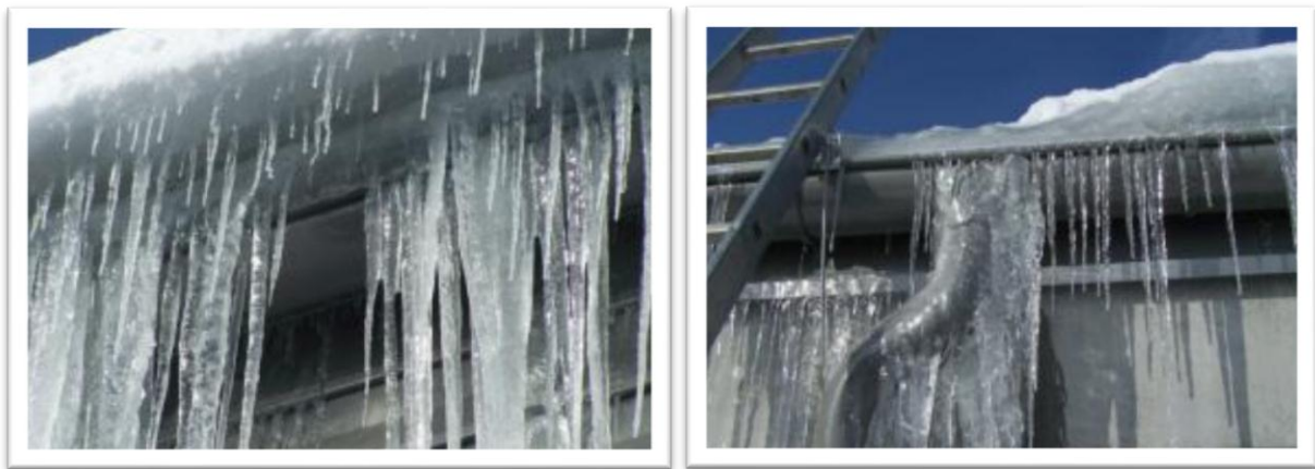
Abb. 1: Vereisungen Traufe Zwischenbau bzw. Vordach
